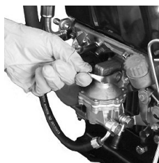
Abb. 43: Entlüftung, Motoren mit Seilstart
